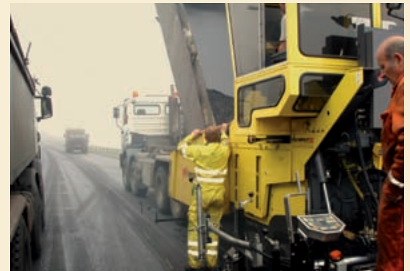
Asfaltið á Landsverki í ferð við at asfaltera.
