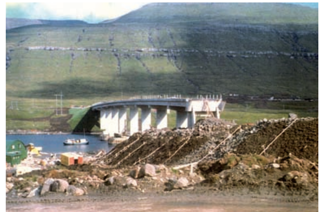
Arbeiðið upp á at gera yvirbyggingin á brúnni byrjaði í apríl mánaði í 1972.
