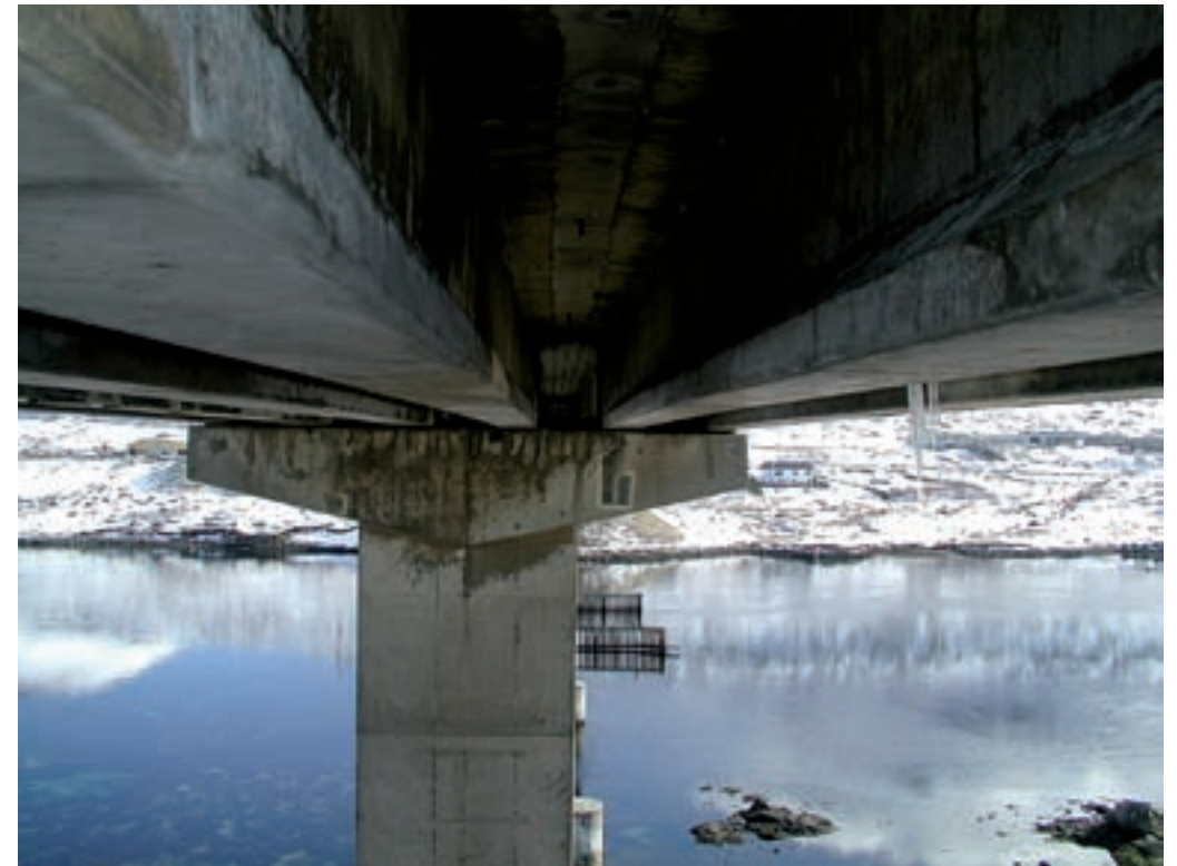
Arbeiðið at gera undirstøðið byrjaði í mars mánaði í 1971.
