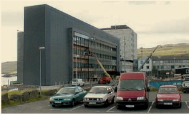
Landssjúkrahúsið í gerð. Landsverk er byggiharri í hesi verkætlan.
