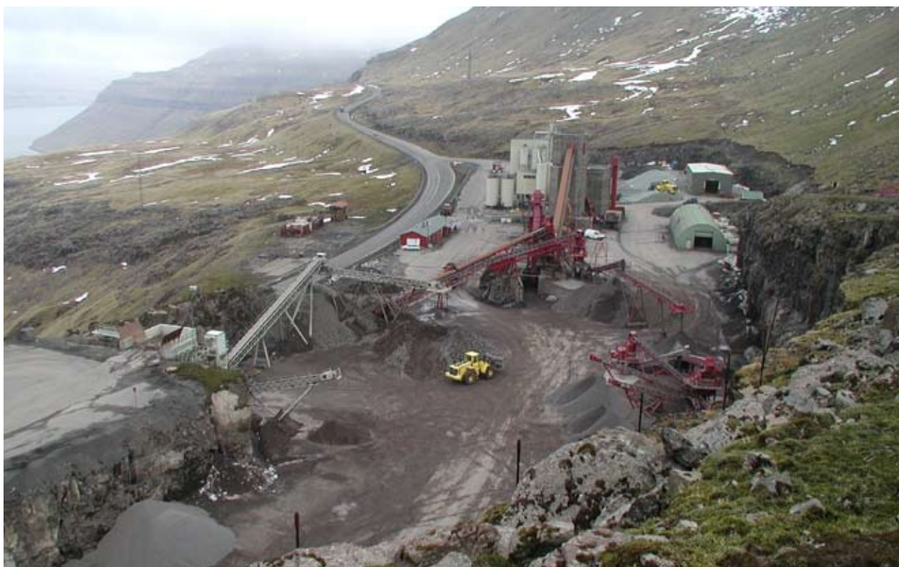
Asfalt- og skervverkið í Hundsarabotni.
