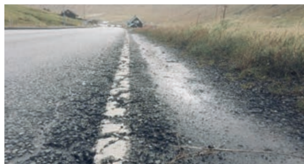
Mynd 3: Ringasta økið á einum teini á 250 m í Kollafirði. Seinastu 7-10 árinu hevur einki skipað viðlíkahald verið av vegjaðaranum.
