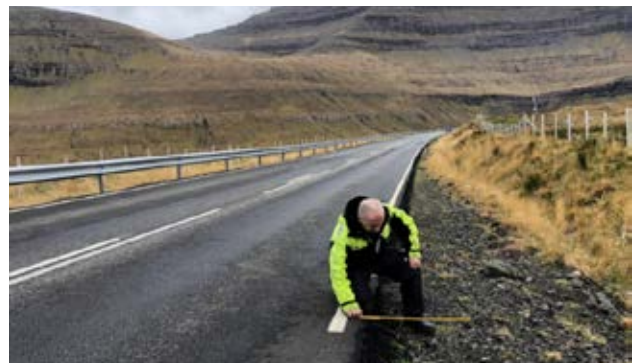
Mynd 6: Vegur við kanti upp til asfaltið
